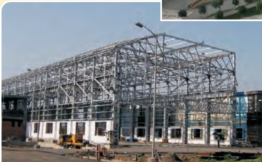
निर्माणाधीन ईएमडी लोको कारखाना/दंकुनी EMD Loco Factory Dankuni Under Construction
