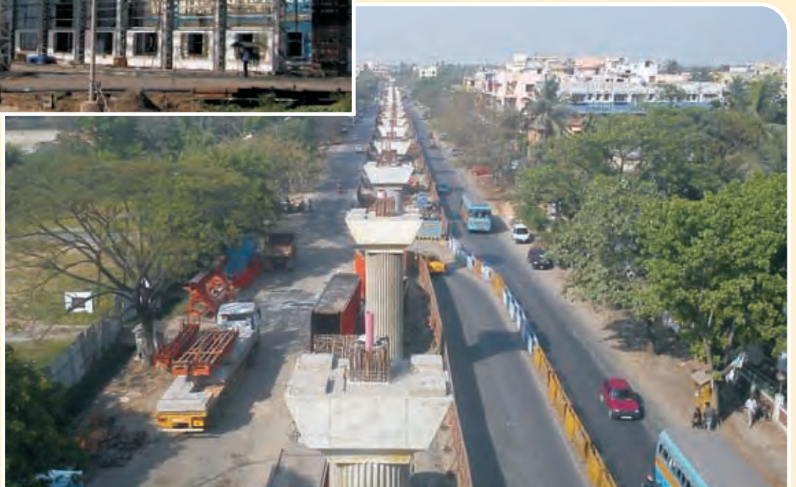
जोका-मोमिनपुर मेट्रो लाइन View of Joka-Mominpur Metro Line, Kolkata
