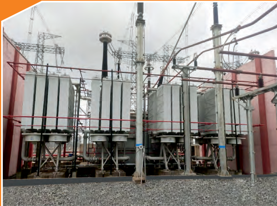
Actual Site Photographs
