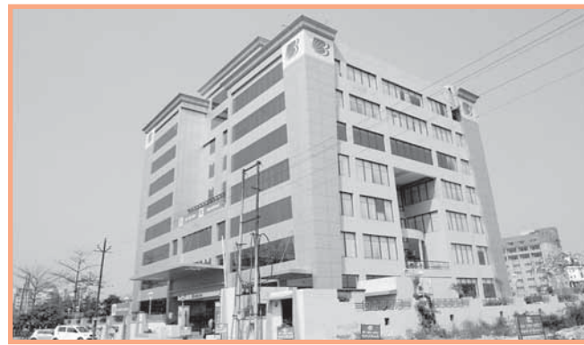
यू.पी.यू. अंचल, लखनऊ का नवनिर्मित भवन
