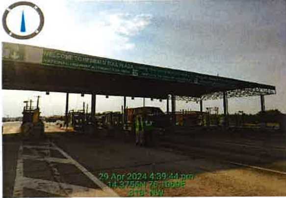
Hebbalu Toll Plaza
