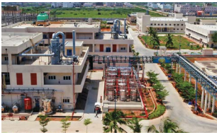
Unit-4, Atchutapuram 1,995 KL A C
