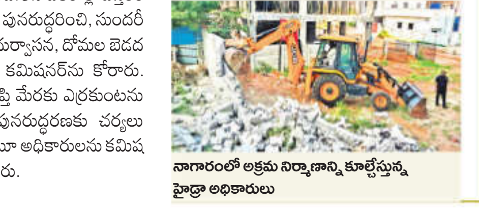
నాగారంలో అక్రమ నిర్మాణాన్ని కూల్చేసిన హైద్రా అధికారులు
