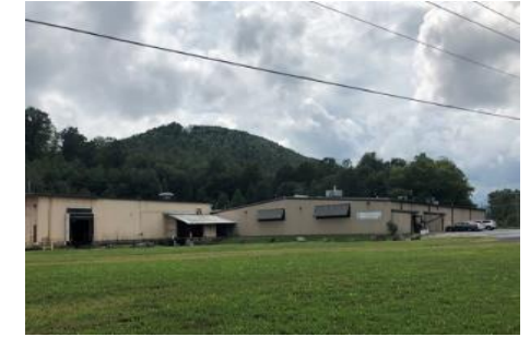
Plant-II, Emporium USA
