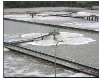
172 MLD STP, Hyderabad, TS
