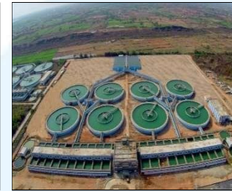
410 MLD WTP, Nalgonda, TS
