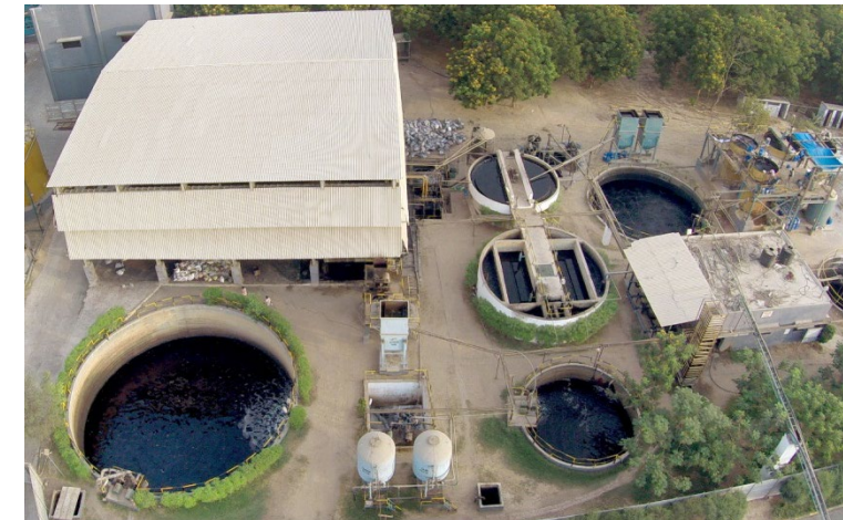
Effluent Treatment Plant (ETP)
