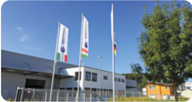
Endurance Gmbh - Massenbachhausen
