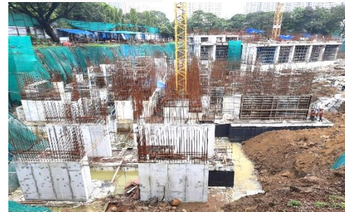
Tower (D) Foundation work in progress
