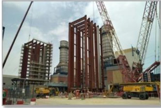
250 MW SABIYA CCPP, KUWAIT INSTALLATION OF HRSG
