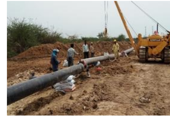
R-LNG PIPELINE FROM ENNORE LNG TERMINAL TO MFL-ENNORE , IOCL
