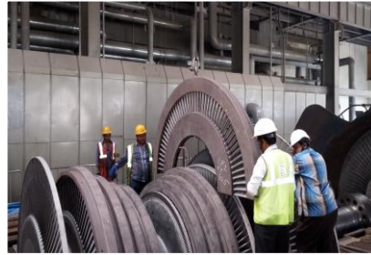
TG OVERHAULING 600MW JHARSUGUDA VEDANTA
