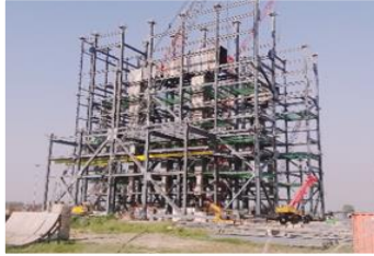
1X660 MW TPP, BTG, HARDUAGANJ, DOOSAN
