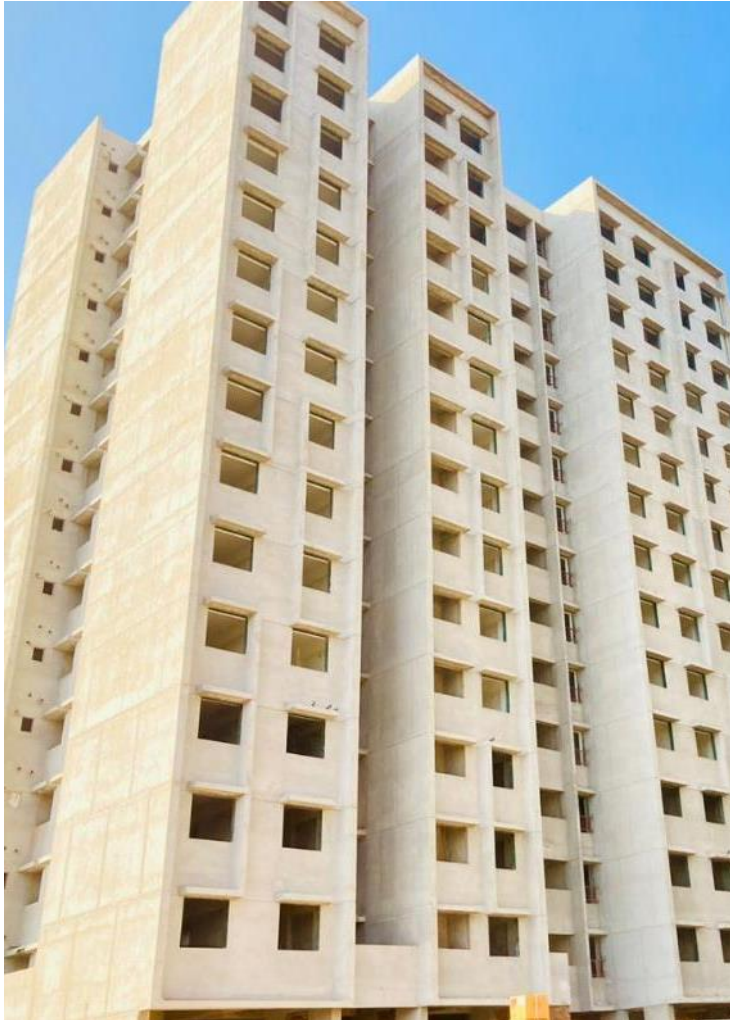
Actual Construction Images
