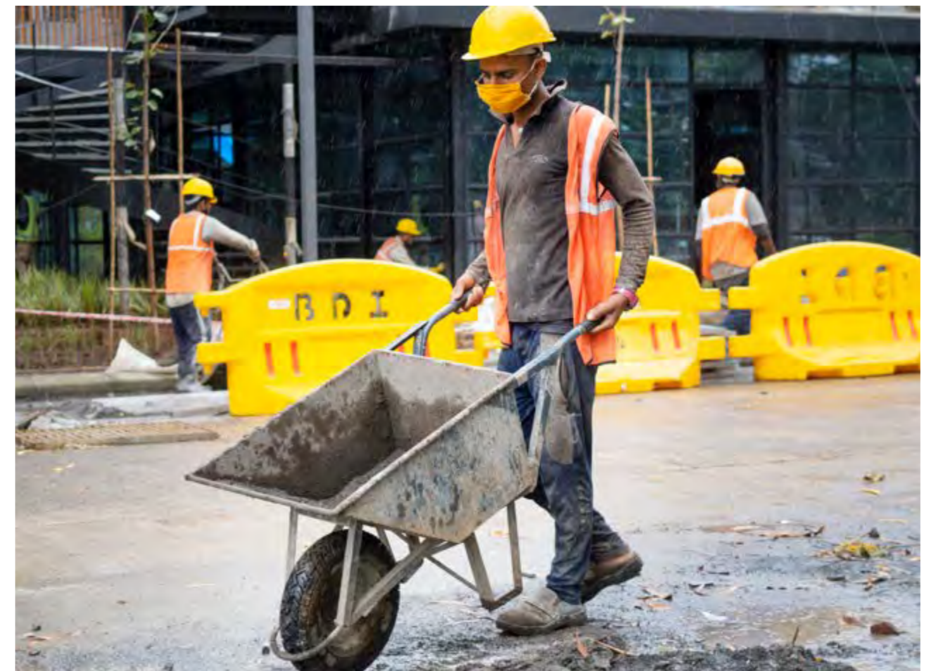
GPL project site
