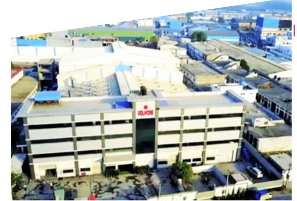
Fan Manufacturing Unit
