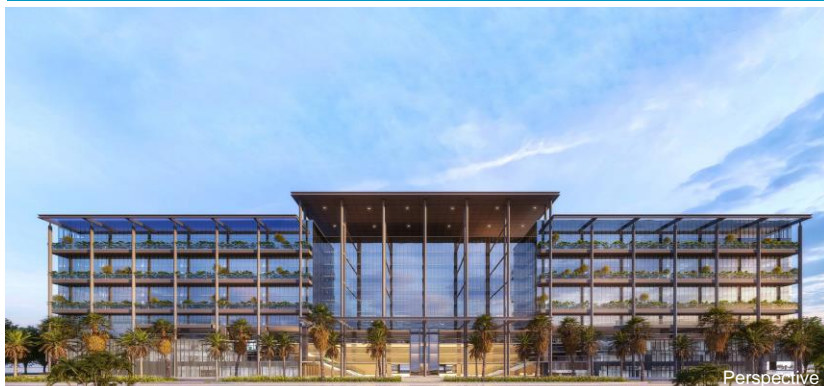
Embassy Manyata – Blocks D1 & D2 (1.4 msf)
