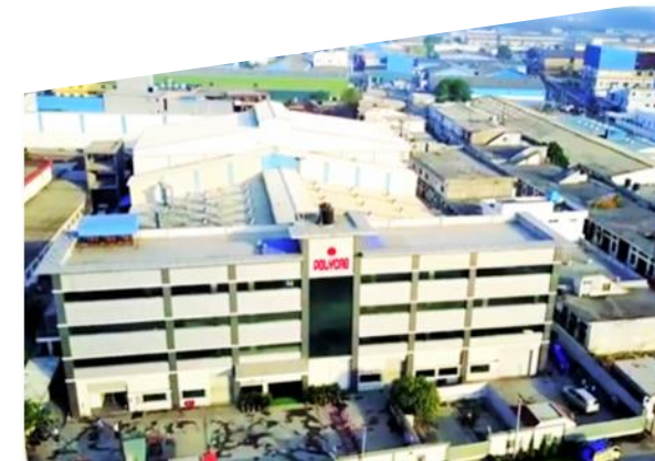
Fan Manufacturing Unit
