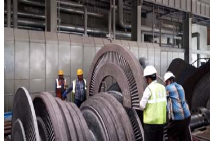
TG Overhauling 600 MW Jharsuguda Vedanta
