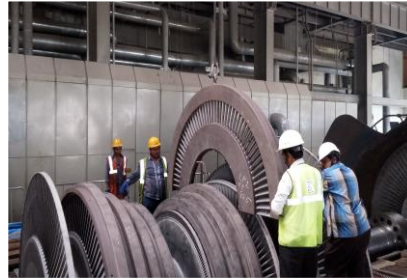
TG OVERHAULING 600MW JHARSUGUDA VEDANTA
