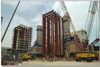
250 MW SABIYA CCPP, KUWAIT INSTALLATION OF HRSG
