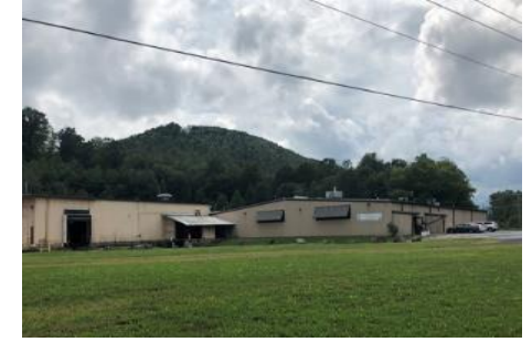
Plant-II, Emporium USA
