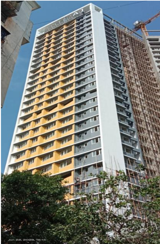
Tenant Building – Ave Maria
