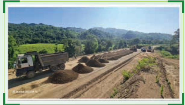
GSB Top Layer Laying @KM 3+400, Myanmar
