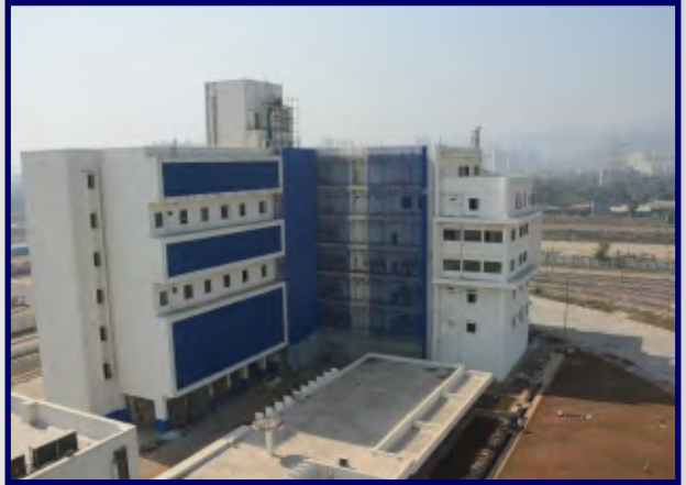
CIDCO Metro Depot
