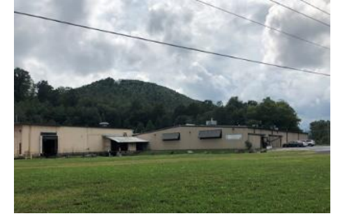
Plant-II, Emporium USA
