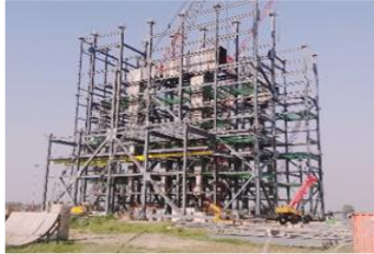
1X660 MW TPP, BTG, HARDUAGANJ, DOOSAN
