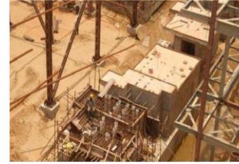
3X660 MW, STPP, STG,BOP ,NORTH KARNAPURA, BHEL
