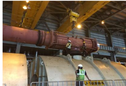
TURBINE AOH, 600 MW UDIPI
