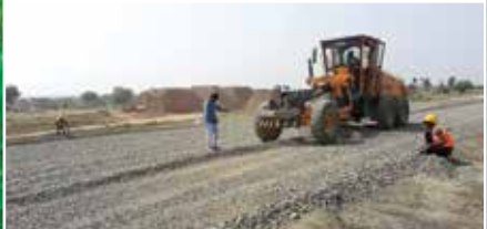
Granular Sub Base (GSB) layer
