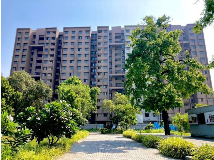
Actual Construction Images
