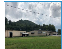
Plant-II, Emporium USA
