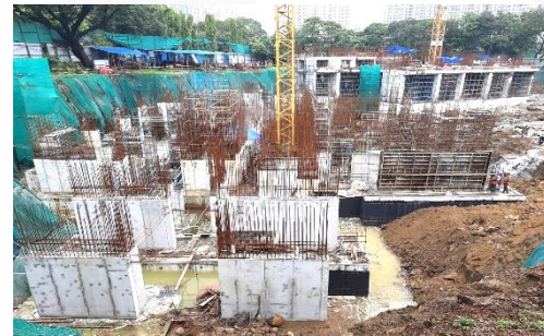
Tower (D) Foundation work in progress
