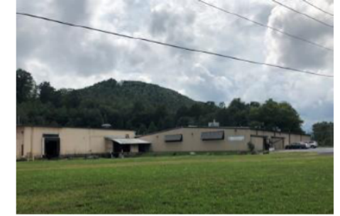
Plant-II, Emporium USA
