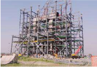
1X660 MW TPP, BTG, HARDUAGANJ, DOOSAN
