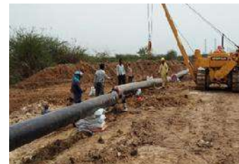
R-LNG PIPELINE FROM ENNORE LNG TERMINAL TO MFL-ENNORE , IOCL
