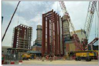
250 MW SABIYA CCPP, KUWAIT INSTALLATION OF HRSG
