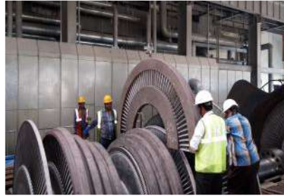
TG OVERHAUING 600MW JHARSUGUDA VEDANTA
