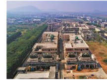
Unit-4, Atchutapuram 1,959 KL A C
