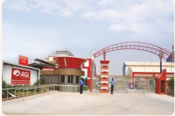
AGL Dalpur Plant (Wall Tiles)
