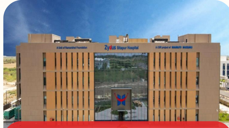
Zydus Hospital Sitapur (Epc Project)
