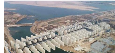
Medigadda Barrage, Telangana
