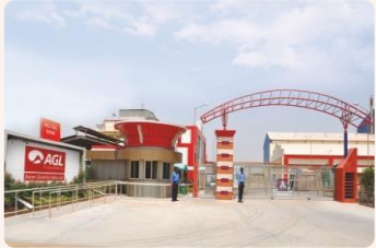
AGL Dalpur Plant (Wall Tiles)
