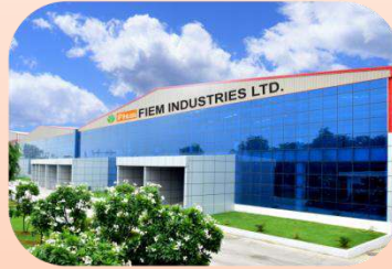
Unit-8, Tapukara (Rajasthan)
