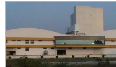
Palamner Plant, Andra Pradesh
