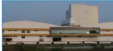
Palamaner Plant, Andra Pradesh
