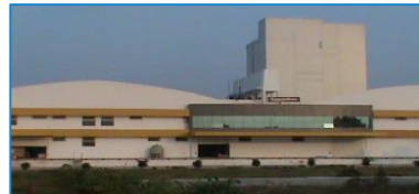
Palamaner Plant, Andra Pradesh
