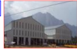
HANGAR I & II
