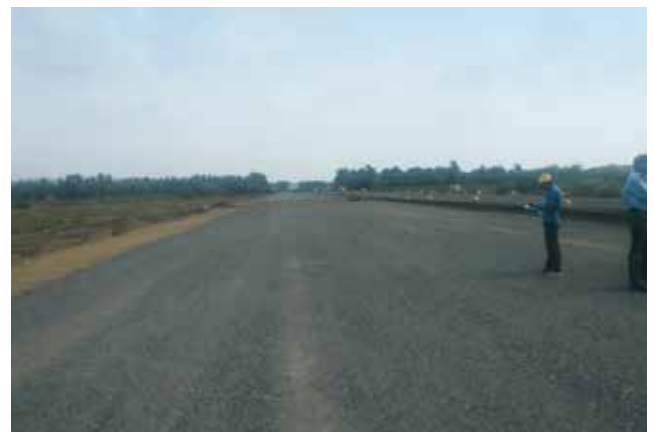
Granular Sub base layer
