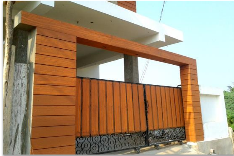
Gate Cladding - (V-Plank)
